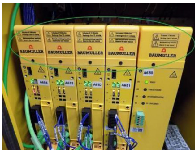
Rysunek B-1 Osłony magistrali DC
