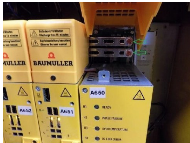
Ábra B-3 DC busz sáv fedél alatt
